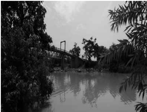
Imagen 2. Contaminación de aguas superficiales cuesta abajo debido a la escorrentía de relaves durante los monzones. Autor: Indrajeet Rajkhowa.
