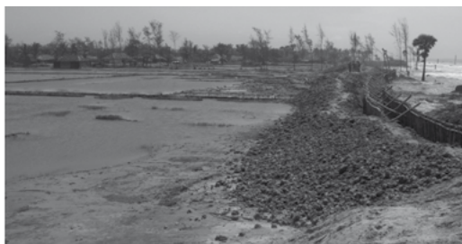
Imagen 3: Dique temporal recién construido en Botkhali. Autor: A. Harms.
