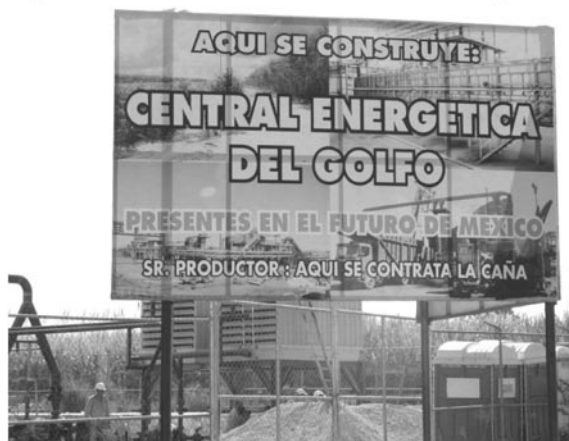
Figura 1 Construcción de la Central Energética del Golfo
