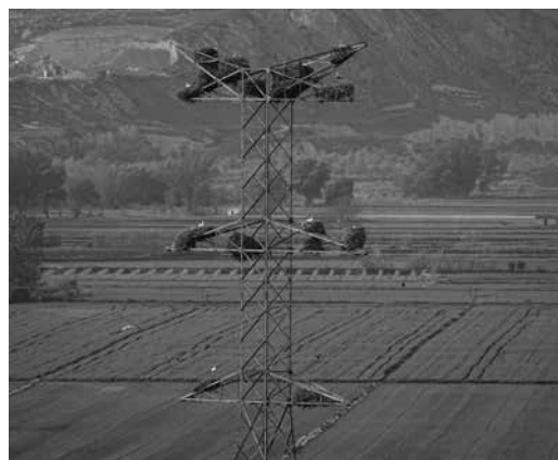
Torre de la línea Aragón-Cazaril colonizada por cigüeñas. (Autor: Alfons Pérez)
