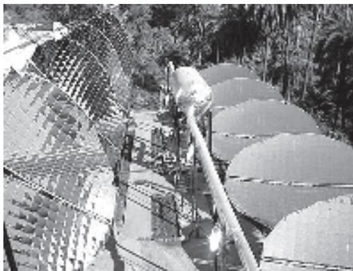
Módulo de 10 reflectores de la instalación del Global Hospital en Mount Abu. Se observan los reflectores a diferente altura, los receptores y el depósito principal donde se almacena el vapor.
