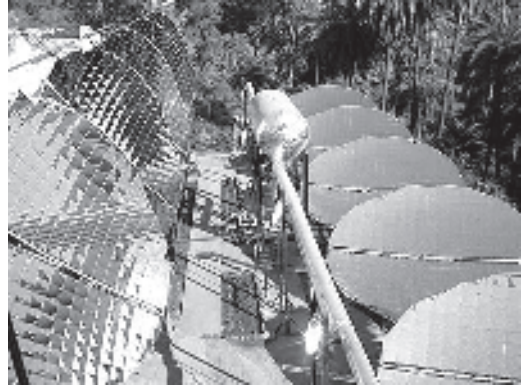
Módulo de 10 reflectores de la instalación del Global Hospital en Mount Abu. Se observan los reflectores a diferente altura, los receptores y el depósito principal donde se almacena el vapor.
